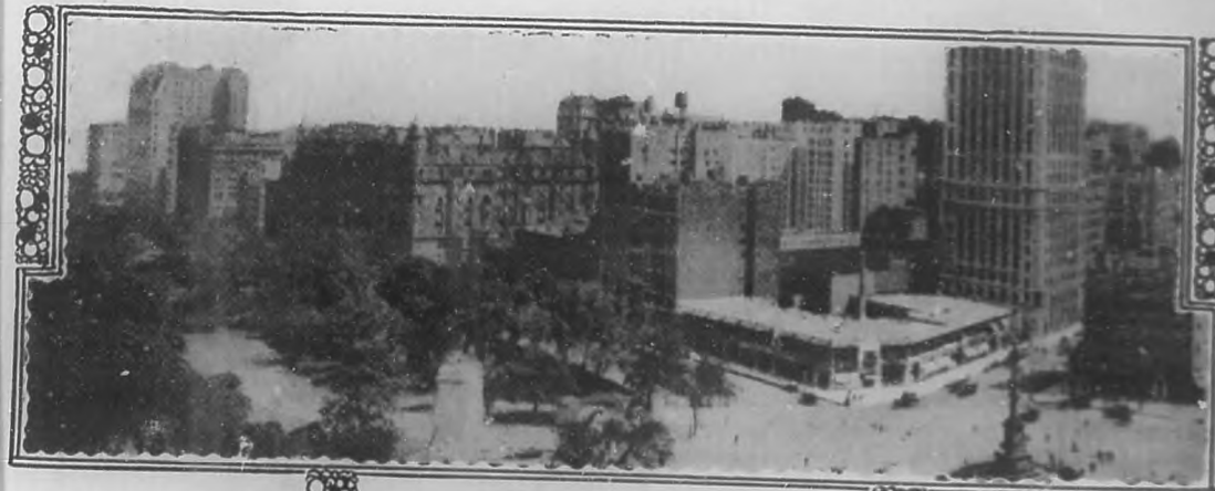
LA ENTRADA AL PARQUE CENTRAL EN "COLUMBUS CIRCLE"
